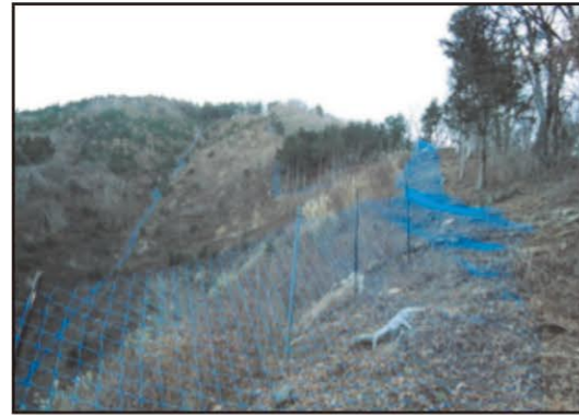
(ネット設置施工例)
