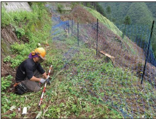
5. アンカー杭 固定
